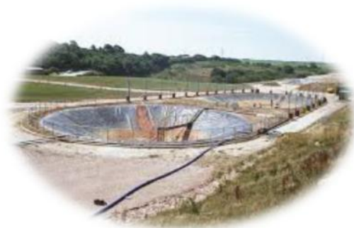
Депонија са ободним каналима за отицање воде са фолије
