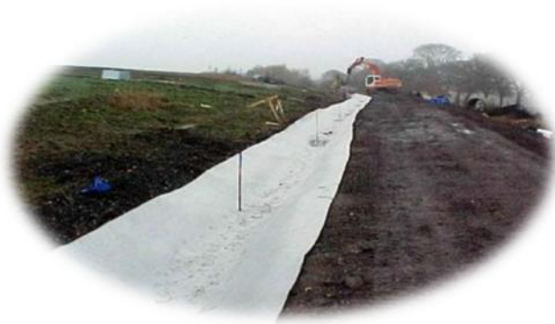
Депонија са ободним каналима за отицање воде са фолије
